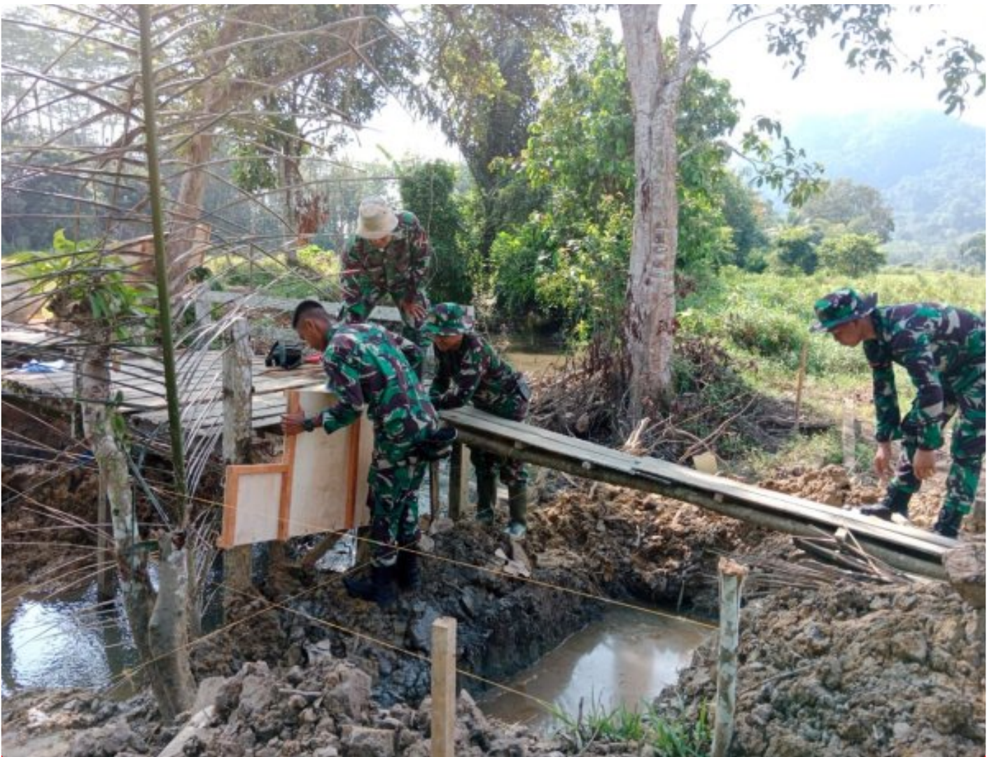
Satgas TMMD ke-116 Kodim 1002/HST Dikerjakan Jembatan
