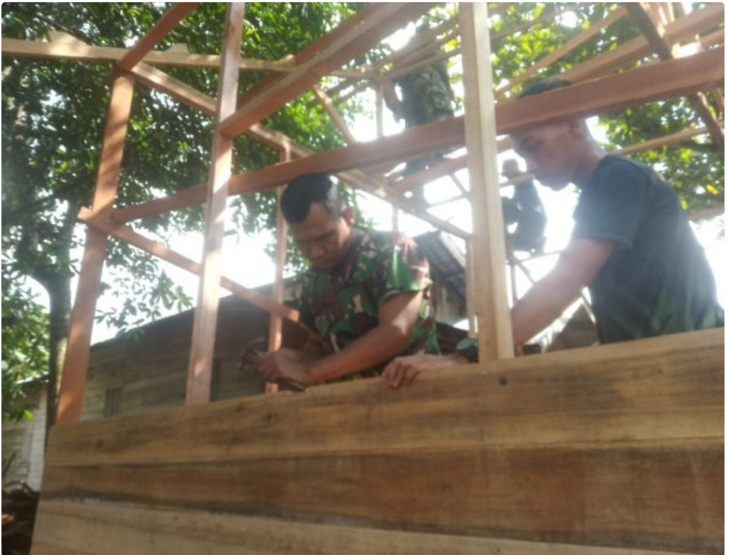
Rehab Tidak Layak Huni TMMD Ke-116 Kodim HST Pasang Dinding Dan Lantai Rumah
