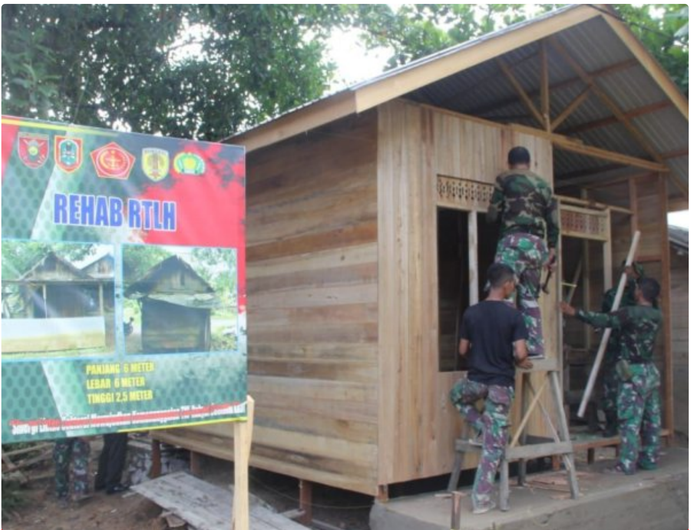
Pengerjaan Rehab RTLH Milik Kakek 86 Tahun Warga Desa Hapulang Capai 55 Persen
