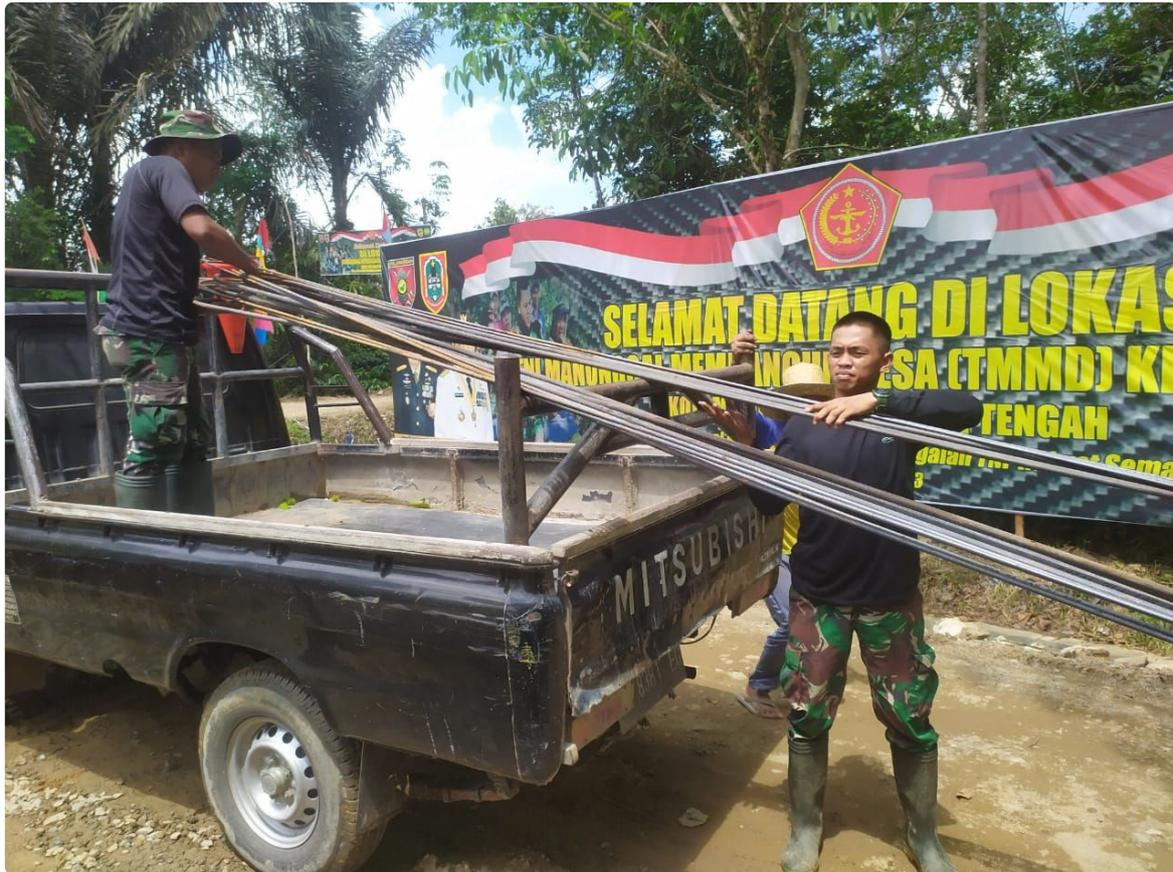
Dijelaskan oleh Pasilog Satgas TMMD ke-116 Kodim 1002/HST Kapten Czi Obet Subagiyo, material besi, papa, kaso, untuk pembuatan abutment jembatan hari ini kita drop ke lokasi, Selanjutnya dilakukan perakitan tulangan besi dan pemasangan begesting sebelum dilakukan pengecoran,"terangnya
