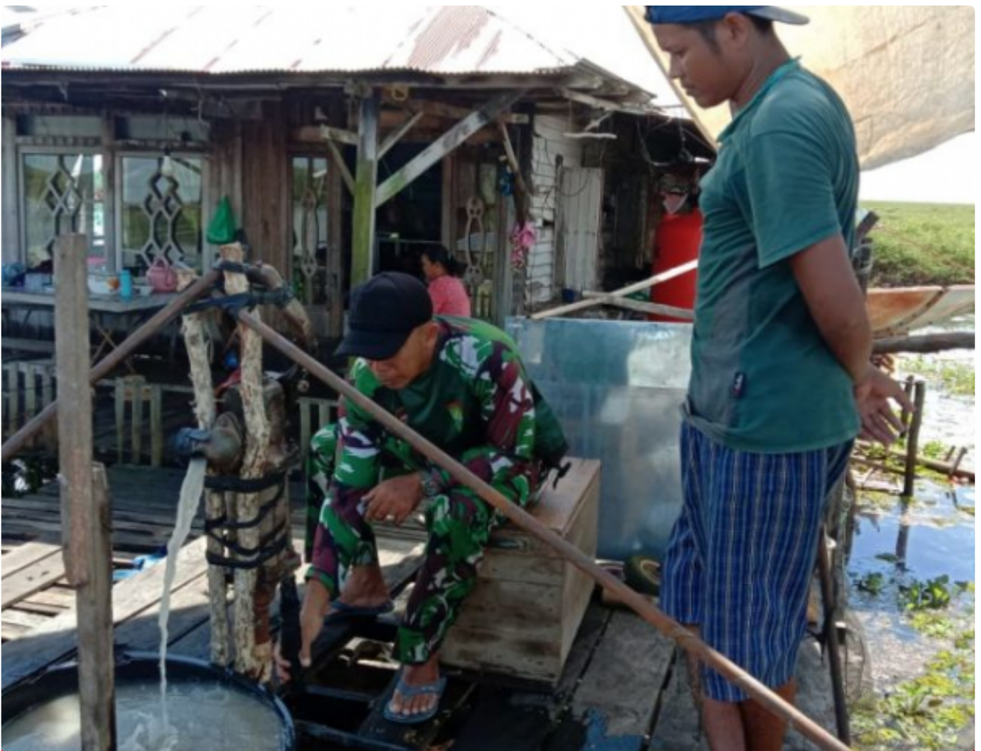
Serka Saipul Fadillah Bantu Perbaikan Pompa Air Warga Binaan
