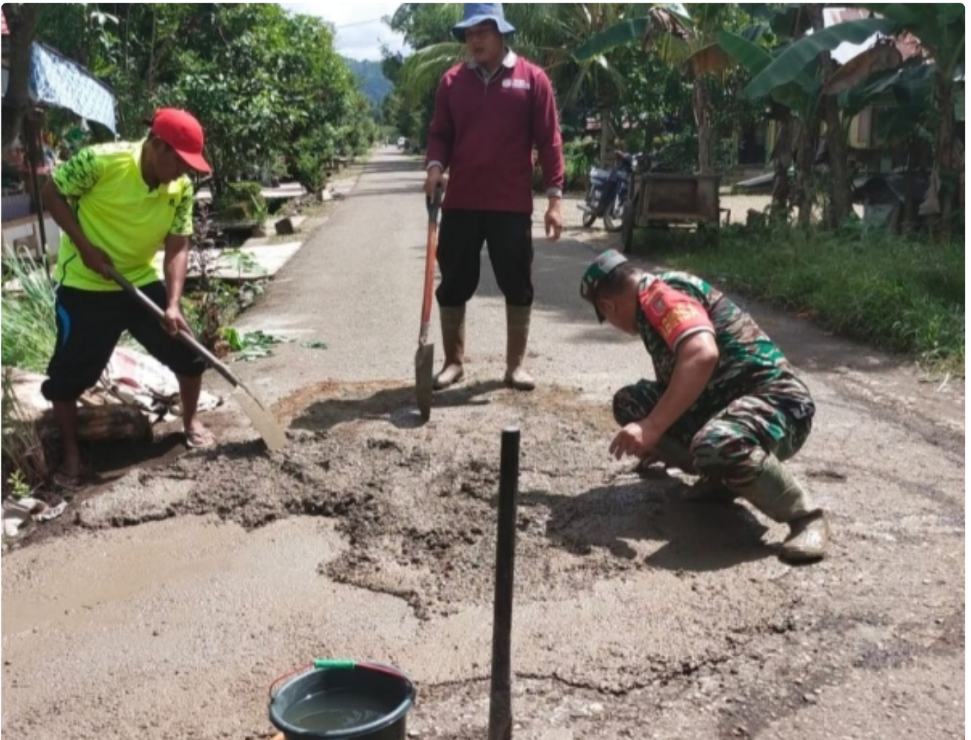
Babinsa Koramil 03/Haruyan Serda Yunus Suyanto bersama Aparat Desa Tabat Padang Perbaiki Jalan Rusak
